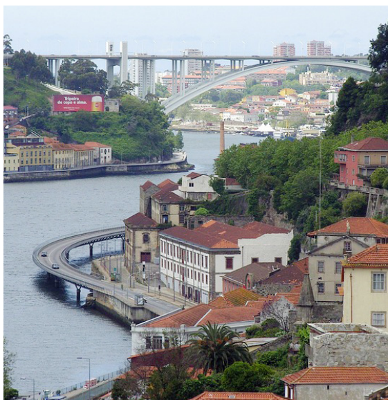
Ponte de Dom Luís I (Dom Luís I-broen) i Porto
