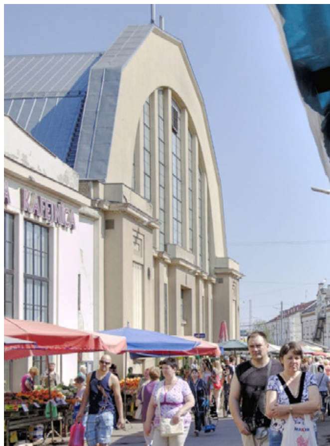
Centralmarkedet i Riga blev opført 1924-30 ved genbrug af fire tyske Zeppelin-hangarer. Det er blandt Europas største markeder.
